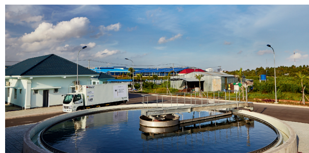
Mit Hilfe des mobilen Labors „MobiLab“ der Firma LAR kann die Abwasserqualität flexibel und direkt vor Ort in den jeweiligen Kläranlagen gemessen werden.
